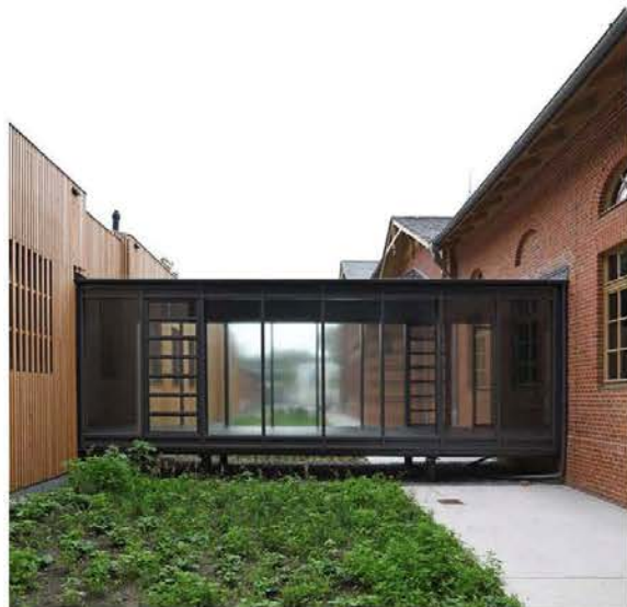
Verbindung zum neuen Küchenbau | Connection to the new kitchen building
