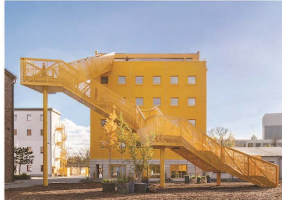
Ansicht vom Hof | View from the courtyard
