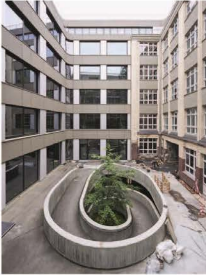
Fahrradrampe am Senkgarten | Cycle ramp at the sunken garden
